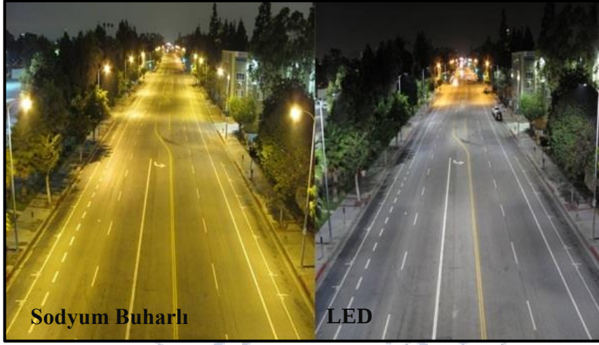
Şekil 1.1: Power LED ile Sodyum Buharlı Sokak Aydınlatma [6]
