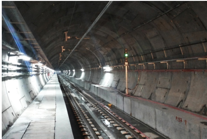
Şekil 4.3: Marmaray Rijit Katener Sistemi
