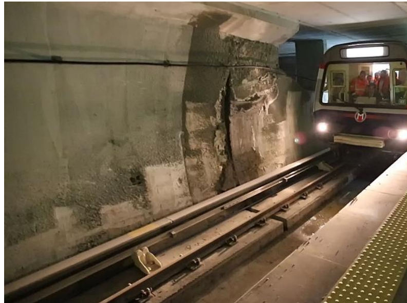
Şekil 4.4: Levent-Hisarüstü Metrosu 3. Ray Uygulaması
